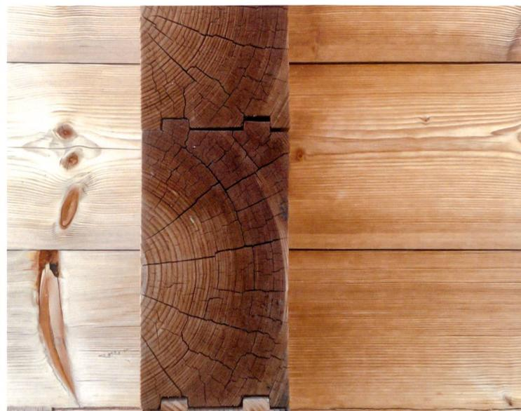
In den Ecken der **Aussenwände des Strickbaus** auf der Wiesner Alp sind die massiven, unisolierten **12 cm dicken Holzbalken** sichtbar.
