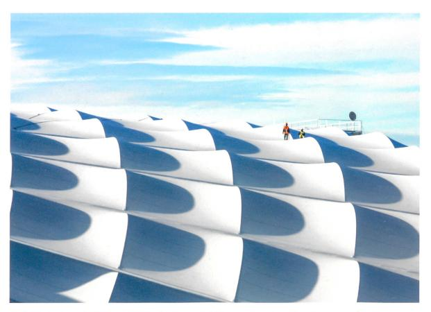
Die 65 000 m² weite, **semitransparente Hülle** des Stadions aus PTFE (Polytetrafluorethylen) dient als Sonnen- und Windschutz. Die Folien werden mittels radialer Vorspannung auf einem Gerüst, bestehend aus Stahlbögen, in Form gebracht.
