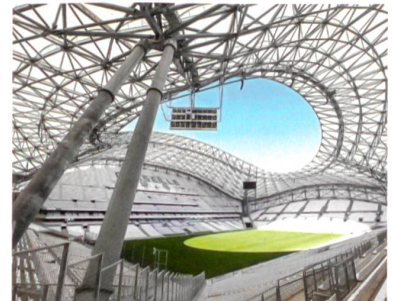
Endzustand: Das Kuppelauge und das vertikale Fachwerk des «Rocks» sind geschlossen und bilden die Auflager der Fachwerkträger.
