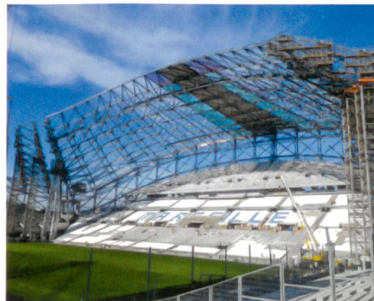
Bauphase Spielsaison: Die Gerüsttürme wurden durch einen Bogen (Dachsegment) mit Zugband (Kabel zwischen Megastützen) ersetzt. Der Blick auf das Spielfeld ist frei.
