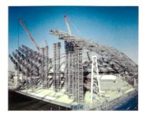
Bauphase Zwischensaison: Provisorische Gerüsttürme sind auf die Tribünen gesetzt und stützen die radialen Fachwerke vertikal ab.
