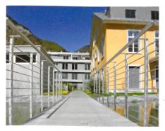
Beeindruckende Fensterhöhe mit VEKA Profilen aus dem System SOFTLINE 70 MD: Ein Teil der Fenster wurde in einer Grösse von 1400×2660 mm erstellt.
