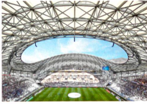
Das Stade Vélodrome in Marseille mit der neuen Überdachung und Fassade aus Stahlfachwerken und PTFE-Folie. Das 6000 t schwere Dach stützt sich auf vier paarweise angeordnete Megastützen in den Ecken der Tribünen sowie auf acht vertikale Aussenstützen, ohne die historische Bausubstanz zu tangieren.
