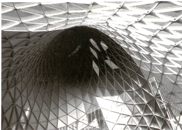
Beispiele von statisch unbestimmten, als Gitterschalen ausgebildeten Freiformflächen. Links: Dach der neuen Messe in Mailand von Massimiliano Fuksas (2005). Rechts: Centre Pompidou in Metz von Shigeru Ban (2010).
