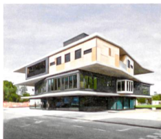
Das NEST-Gebäude am Tag vor seiner Eröffnung: Auf den auskragenden Geschossdecken stehen provisorische Einheiten, sogenannte Units, in denen wechselnde Partner aus Forschung und Industrie gemeinsam neue Materialien, Produkte und Systeme entwickeln. Im 2. OG ist «Vision Wood» zu sehen.
