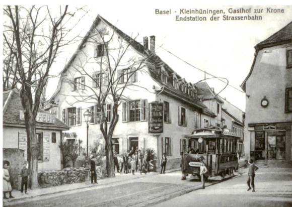
Als das Tram noch bis ins Dorf fuhr: Endstation der Basler Strassenbahn vor dem Gasthof zur Krone . 1897 erreichte das Tram das damals noch eigenständige Dorf Kleinhüningen, 1922 wurde eine neue Wendeschleife bei der Brücke über die Wiese gebaut. Der Gasthof zur Krone verschwand bereits 1945, das Haus rechts mit dem ehemaligen Postbüro steht heute noch. Postkarte, um 1910.
