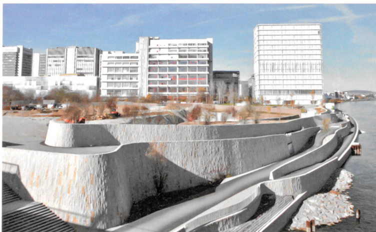
Wege in zwei Ebenen: Die obere, hochwassersichere Ebene bietet Spaziergängern Verweilplätze, während die untere sich als Ausstieg für Rheinschwimmer anbietet.
