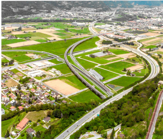
Im Vordergrund die Ceneri-Basistunnelportale. Aus dem linken kommt der Viadukt Lugano-Bellinzona. Der tiefer liegende, parallel verlaufende Viadukt für die Gegenrichtung ist ähnlich gestaltet, konzeptionell aber wesentlich anders.
