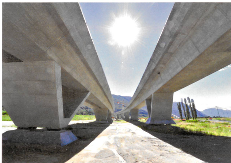
Die Brückenaufleger können nachträglich um bis zu 100 mm angehoben werden.
