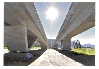
Die Brückenauflager können nachträglich um bis zu 100 mm angehoben werden.
