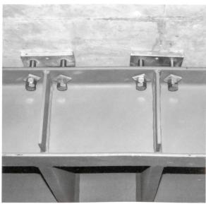
Zwei Verfahren zur Vorspannung des Stahlpilzes: mittels verlorener Presse zwischen Stützkopf und Pilz (li.) oder mit Schrauben entlang des Randträgers (re.). Seltener sind die ergänzten Pilzabstützungen am Stützenfuss, die aufgepresst und unterfüttert werden.
