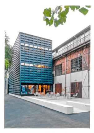
Der neue Vorplatz bildet den Auftakt zum Kulturlokal «Merkker». Die Fassade des Anbaus besteht aus Gussstahlelementen, die auf die frühere Nutzung als Schmiede verweisen.
