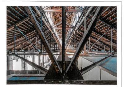
Der englische Dachbinder mit gegen Feldmitte abfallenden Diagonalen stellte eine für diese Zeit übliche und zweckmässige Binderform dar. Interessant ist die Anordnung des Windverbands auf der Ebene des Untergurts. Nebst den statisch-konstruktiven Vorteilen eines liegenden Gitterträgers konnte der In-
