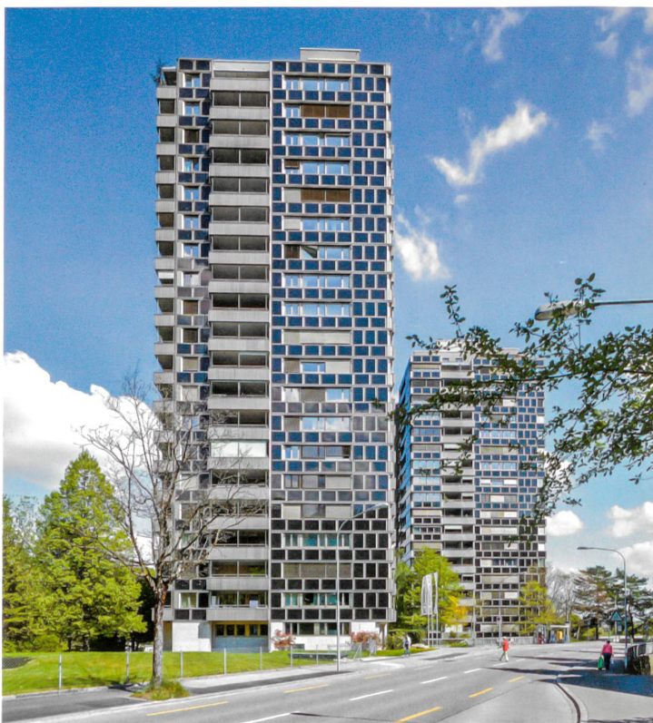
FHNW-Forscherin Dr. Monika Hall hat ihre Simulation unter anderem an diesen Wohnhochhäusern an der Sihlweidstrasse in Zürich validiert, das von Harder Haas Architekten saniert wurde.
