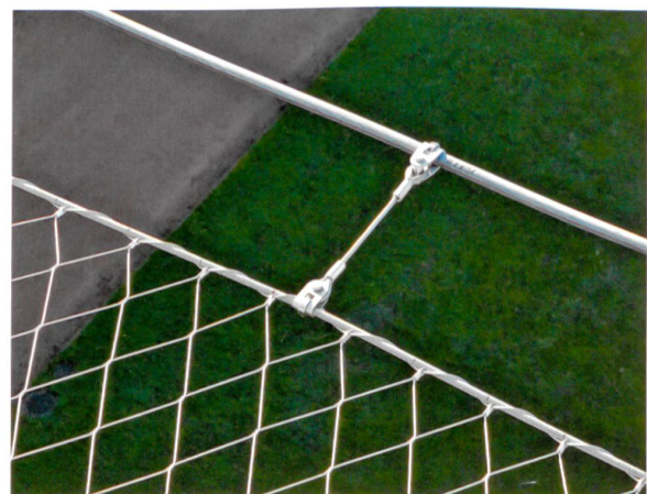
Die feuerverzinkten Beschläge und Seilverbindungen sind schlank ausgebildet.
