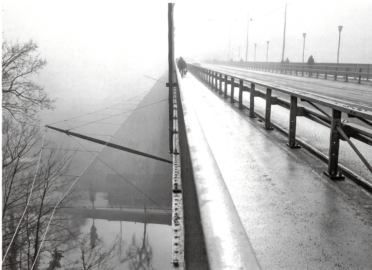
Das Fangnetz an der Kirchenfeldbrücke als kontinuierliches Band: Im weitmaschigen Edelstahlseilnetz (Maschen: 180×313 mm; 3 mm Drahtseile) sind die Maschen hülsenlos zusammengeflochten. Einzelne Netzteile (parabelförmiges Schnittmuster) sind mit Verpresshülsen auf der Baustelle zusammengefügt worden und können künftig ausgetauscht werden.
