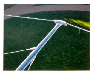
Das Tragseil wird über die Spitze der Ausleger mit Abrollsattel geführt.
