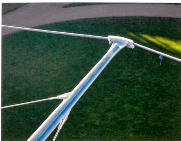
Das Tragsseil wird über die Spitze der Ausleger mit Abrollsattel geführt.
