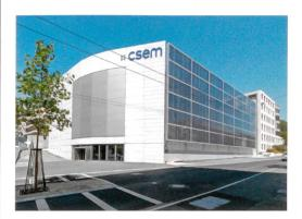
Nach der Instandsetzung: Die postmoderne Hauptfront mit dem Logo auf der Westseite blieb weitgehend unverändert. Neu ist die Fassade mit den PV-Elementen, die vor die bestehende Südwand gestellt wurde. Sie vereinheitlicht die Höhe des Baus und rückt ihn in die Strassenflucht.
