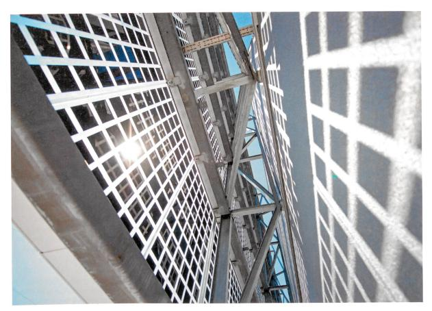
Die neue, vor die Südwand gesetzte PV-Fassade ist mit einer Metallstruktur befestigt. Die Wand ist silbrig gestrichen und reflektiert das Licht, das zwischen den quadratischen PV-Zellen durch das Sicherheitsglas dringt. Die vom CSEM entwickelten bifazialen PV-Zellen nutzen dieses reflektierte Licht, was ihren Wirkungsgrad um geschätzte 10%–20% erhöht.
