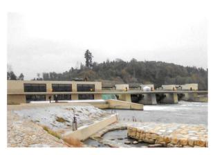
Das Maschinenhaus ist in das Wehr integriert. Über die Wehrbrücke führt eine beliebte Veloroute entlang des Bielersees.
