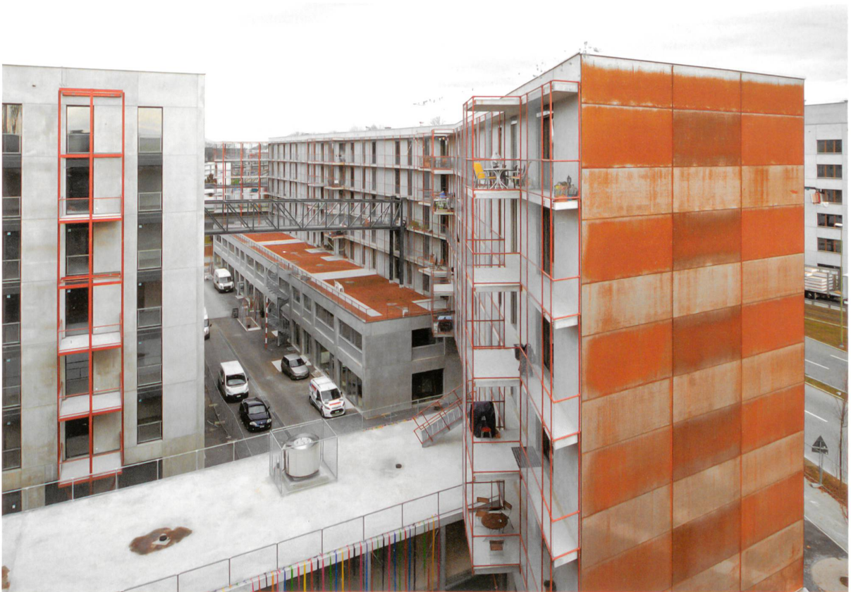
Die roten Stahlstrukturen der Balkone und Laubengänge werden in Zukunft mit Pflanzen bewachsen sein und so das Quartier begrünen.
