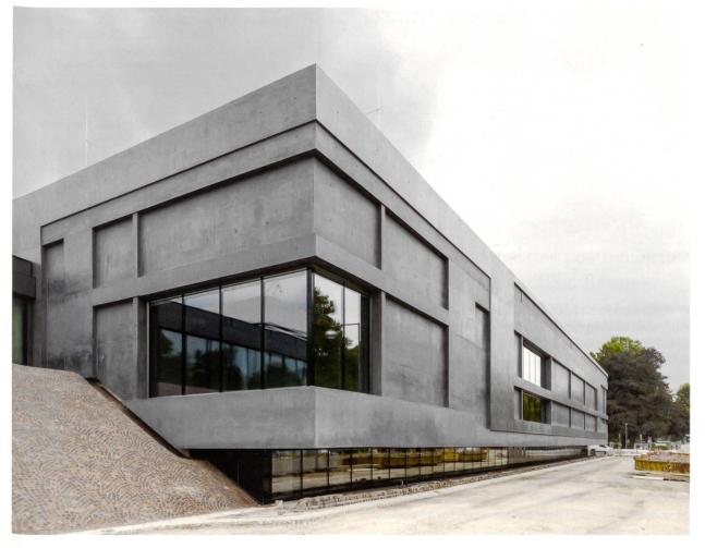
Die Aussenhaut der zweischaligen Hauptfassade des Sprengel-Museums verformt sich infolge Temperatur und Betonschwinden an den Ecken um bis zu 27 mm in Längsrichtung. Die einschaligen Stirnfassaden folgen zwängungsfrei.
