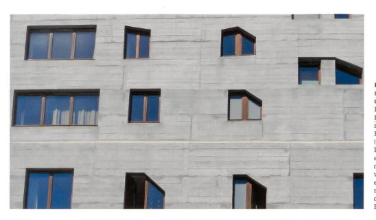
Radikale Instandsetzungsarbeit aus den 1990er-Jahren: Die gesamte Fassade des rückwärtigen Bühnentrakts (1800 m<sup>2</sup>) wurde bis zu 4 cm tief abgetragen und durch neuen Beton von 7 cm Stärke ersetzt. Silikonmatrizen kopierten die originale Betontextur.
