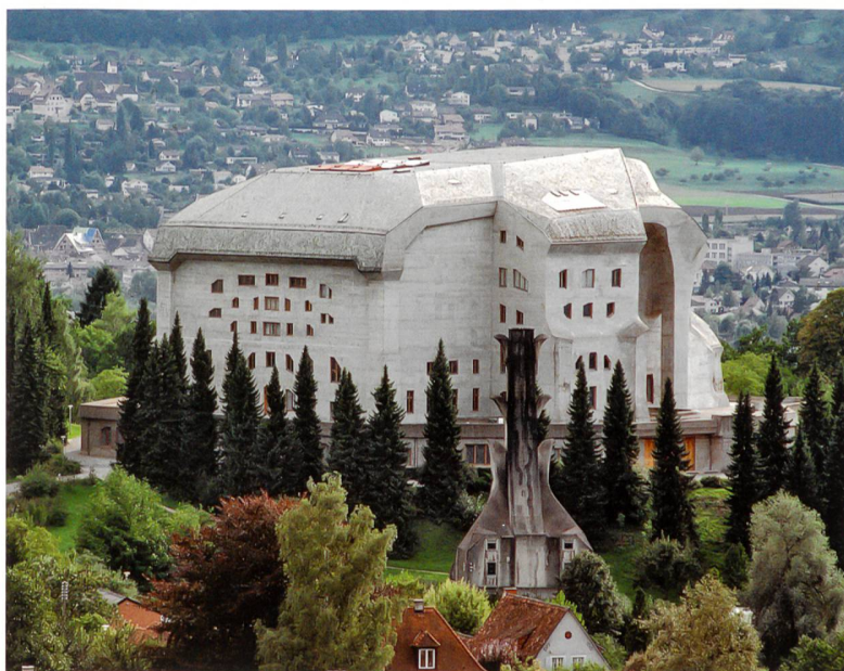
Eine ewige Baustelle: die Instandhaltung der Betonfassade des Goetheanums.
