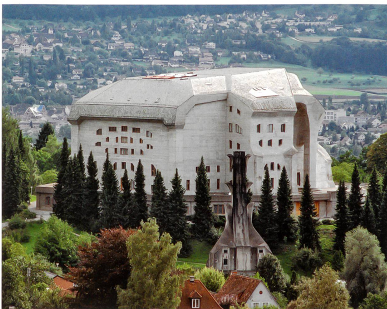
Eine ewige Baustelle: die Instandhaltung der Betonfassade des Goetheanums.
