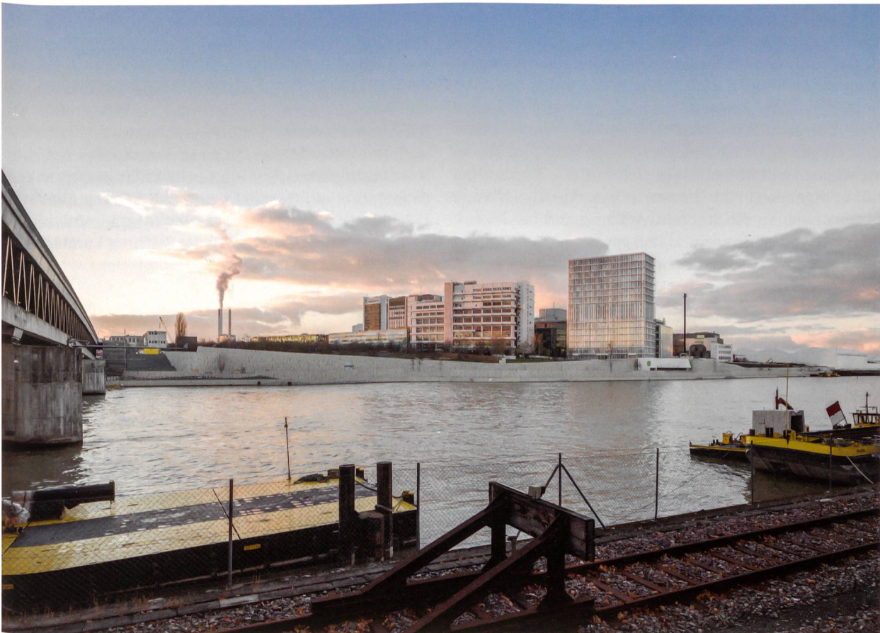
Das Roche-Areal mit dem Roche-Tower (oben) und das Novartis-Areal (unten) prägen das Stadtbild von Basel weiträumig.
