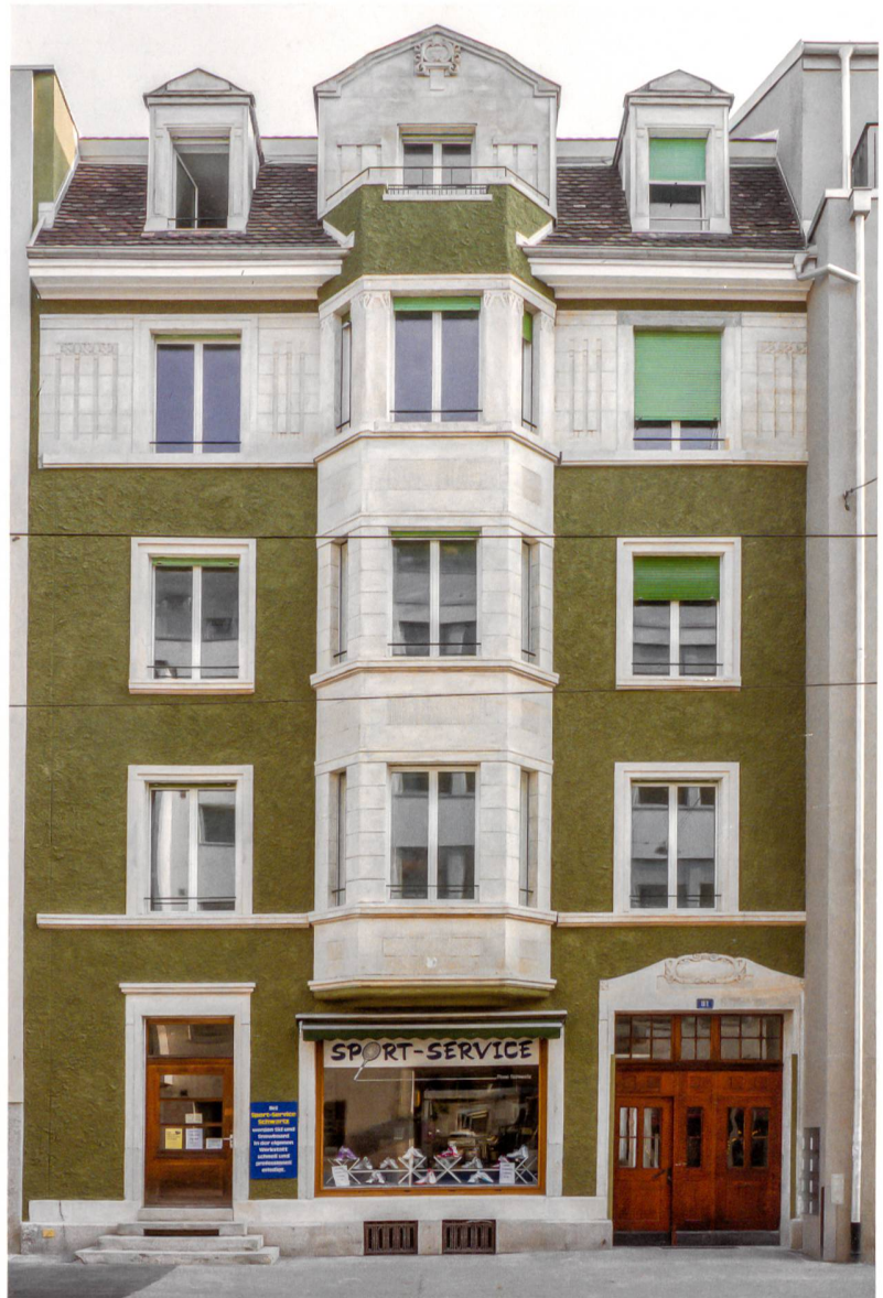
Wirkungsvolle Erneuerung der Hausfassade: Die dünne Dämmschicht ist kaum sichtbar, die Farbveränderung hingegen schon.
