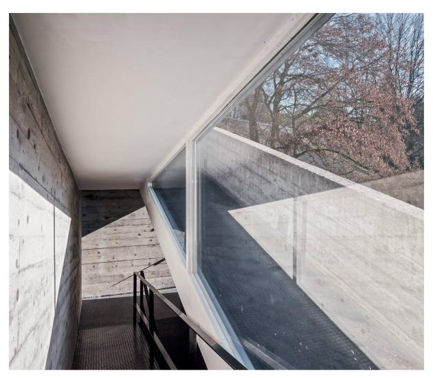
Die betonierte Rampe führt auf der Nordfassade des Baus vom Erdgeschoss zur Dachterrasse. Sie bildet ebenso ein funktionales wie auch ein dokumentarisches Scharnier: als Erschliesssung und Verankerung am Ort und als Hinweis auf die ursprünglich geplante Materialisierung der Kuben.
