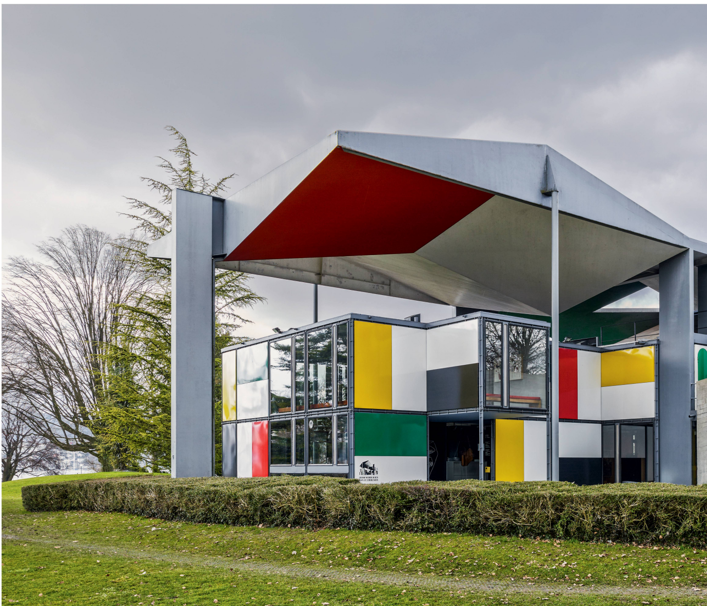
Das zweiteilige Dach schützt und inszeniert den eigentlichen Ausstellungspavillon. Die Fassadenaufteilung der emaillierten Metallplatten und der Raster der Stahlkonstruktion beruhen auf Le Corbusiers Proportionssystem «Modulor».
