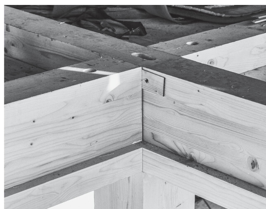
Die Knotenverbindung des Rasters bleibt im Endausbau unsichtbar. Da der Zugang eingeschränkt war, kamen nur kleine Bauteile zum Einsatz.
