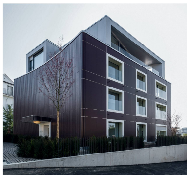
Fassade des ersten Minergie-A-Eco-Mehrfamilienhauses im Kanton Zürich.
