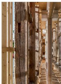
In der Fassade der Scheune in Dingenhart TG trifft das ursprüngliche Gebälk auf das neue Tragwerk im Innern. Was einst das Dach getragen hat, ist nun die Unterkonstruktion für die Fassade; wo früher Heu gelagert wurde und Landmaschinen eingesetzt waren, wohnen nun Städter mit Sehnsucht nach dem Geläut von Kuhglocken und der dampfenden Erde frisch gepflügter Äcker.
