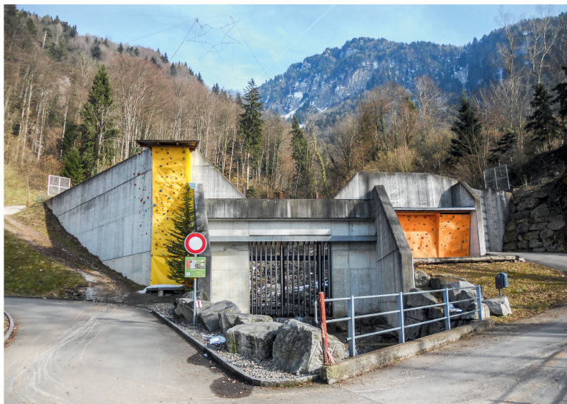
Geschiebesammler im Einzugsgebiet des Altdorfbachs in Vitznau. Seine Kapazität vermag lediglich das Material eines Murgangereignisses mit Wiederkehrdauer von 30 Jahren aufzunehmen.
