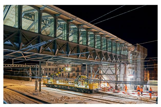
Der Hochperron der Arth-Rigi-Bahn in Goldau, einem Reitergebäude über den Gleisen der SBB-Linie Luzern-Lugano bzw. der Gotthardbahn. Seit Februar 2015 steht er angehoben, aber in der originalen Stahlkonstruktion um 72 cm erhöht auf neuen Auflagern.
