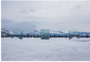
Die gläsernen Oberlichter auf dem Dorfplatz von Rigi Kaltbad leiten das Tageslicht in das darunter liegende Mineralbad & Spa von Mario Botta (2010–2012). Coverfoto von Anna-Lena Walther .
