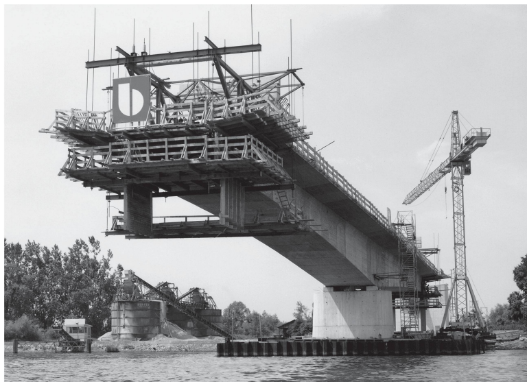
Oben links: Freivorbauverfahren bei der Rheinbrücke am Palmrain 1979. Der Brückenträger wird vom Pfeiler aus nach beiden Seiten hin betoniert, ohne Abstützung des Gerüsts im Flussbett. Oben rechts: Viaduc du Lac de la Gruyère 1979. Im Vordergrund wird der Hohlkasten im Vorschubgerüst betoniert, im Hintergrund werden die Fahrbahnplatte und die Querrippen mit Nachlaufwagen erstellt.
