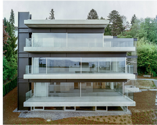
Links: Ansicht des nördlichen Ecks. Im Vordergrund umfassen die Galgenstützen den Lift.
