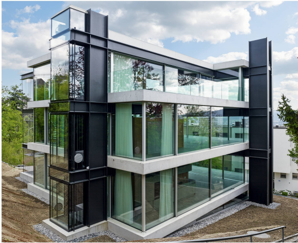
Links: Ansicht des nördlichen Ecks. Im Vordergrund umfassen die Galgenstützen den Lift.
