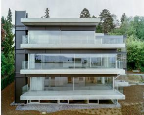
Links: Ansicht des nördlichen Ecks. Im Vordergrund umfassen die Galgenstützen den Lift. Rechts: Ansicht der freigestellten Südwestfassade. Die Zugstützen am auskragenden Ende sind kaum sichtbar.
