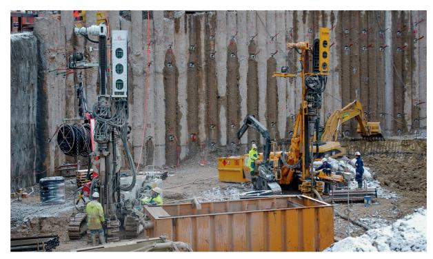
«Erdsonden gehören zu den ersten Installationen, die zu realisieren sind»: Ansicht aus dem Bau des Erdsondenfelds Dolder, Zürich.
