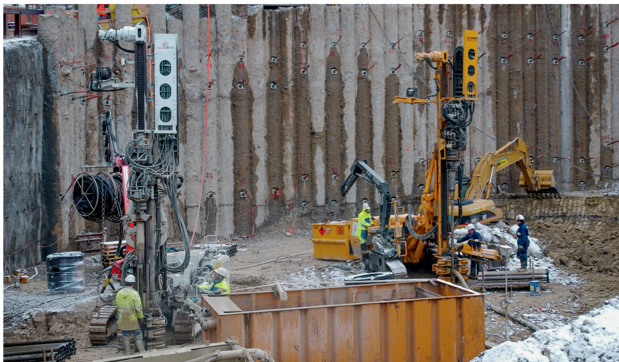
«Erdsonden gehören zu den ersten Installationen, die zu realisieren sind»: Ansicht aus dem Bau des Erdsondenfelds Dolder, Zürich.
