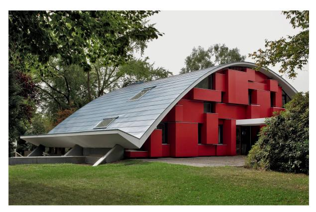
Die Eingangsfassade des Hauses X1 in Köln-Hahnwald ist durch verschiedene Kästen gegliedert, hinter denen sich Schränke, Balkone oder Heizkörper verbergen. Die Krümmung der Dachform folgt einer Klothoide.
