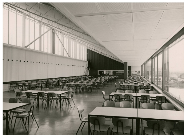
Der Speisesaal mit Sheddach kurz nach Fertigstellung des Baus.
