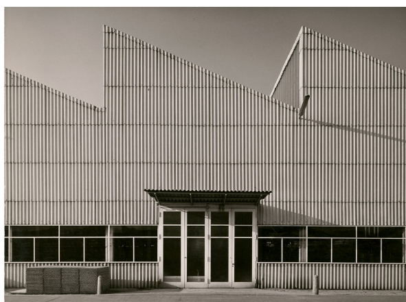
Eternitverkleidet: die Südfassade des Eternit-Werks in Leimen.
