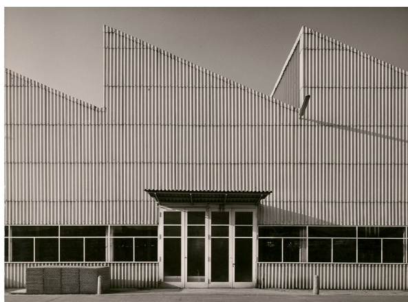
Eternitverkleidet: die Südfassade des Eternit-Werks in Leimen.
