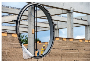
Von aussen sieht man nur die Lehmfassade des Kräuterzentrums. Ein Blick dahinter zeigt die beispielhafte Zusammenarbeit von Ingenieuren, Architekten und Unternehmern – hier noch auf der Baustelle. Coverfoto von Markus Rasom-Bühler .
