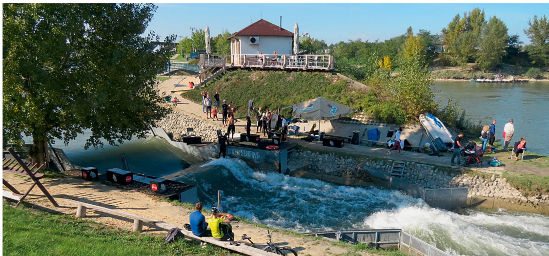
Derzeit kostet die Benutzung der Anlage in Cunovo acht Euro pro Tag. Die Sportler surfen auf einer 7.5 m breiten Welle. Die Wasserfilmdicke beträgt 40 bis 45 cm. Die Schwächen von Anlagen mit relativ niedrigem spezifischem Abfluss können ein erhöhtes Verletzungsrisiko und abgebrochene Finnen sein.
