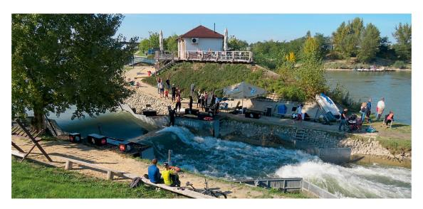
Derzeit kostet die Benutzung der Anlage in Cunovo acht Euro pro Tag. **Die Sportler surfen auf einer 7.5 m breiten Welle**. Die Wasserfilmdicke beträgt 40 bis 45 cm. Die Schwächen von Anlagen mit relativ niedrigem spezifischem Abfluss können ein erhöhtes Verletzungsrisiko und abgebrochene Finnen sein.
