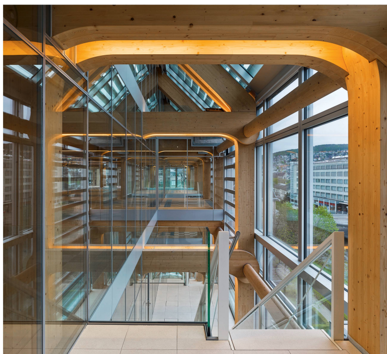
Das 2013 fertiggestellte Tamedia-Gebäude in Zürich ist mit einem bis zu sieben Geschosse hohen Holztragwerk ohne statisch wirksame Stahlteile konstruiert. Architektur: Shigeru Ban Architects; Entwicklung Holzbau: Création Holz; Statik: SJB.Kempeter.Fitze; Holzbau: Blumer-Lehmann.
