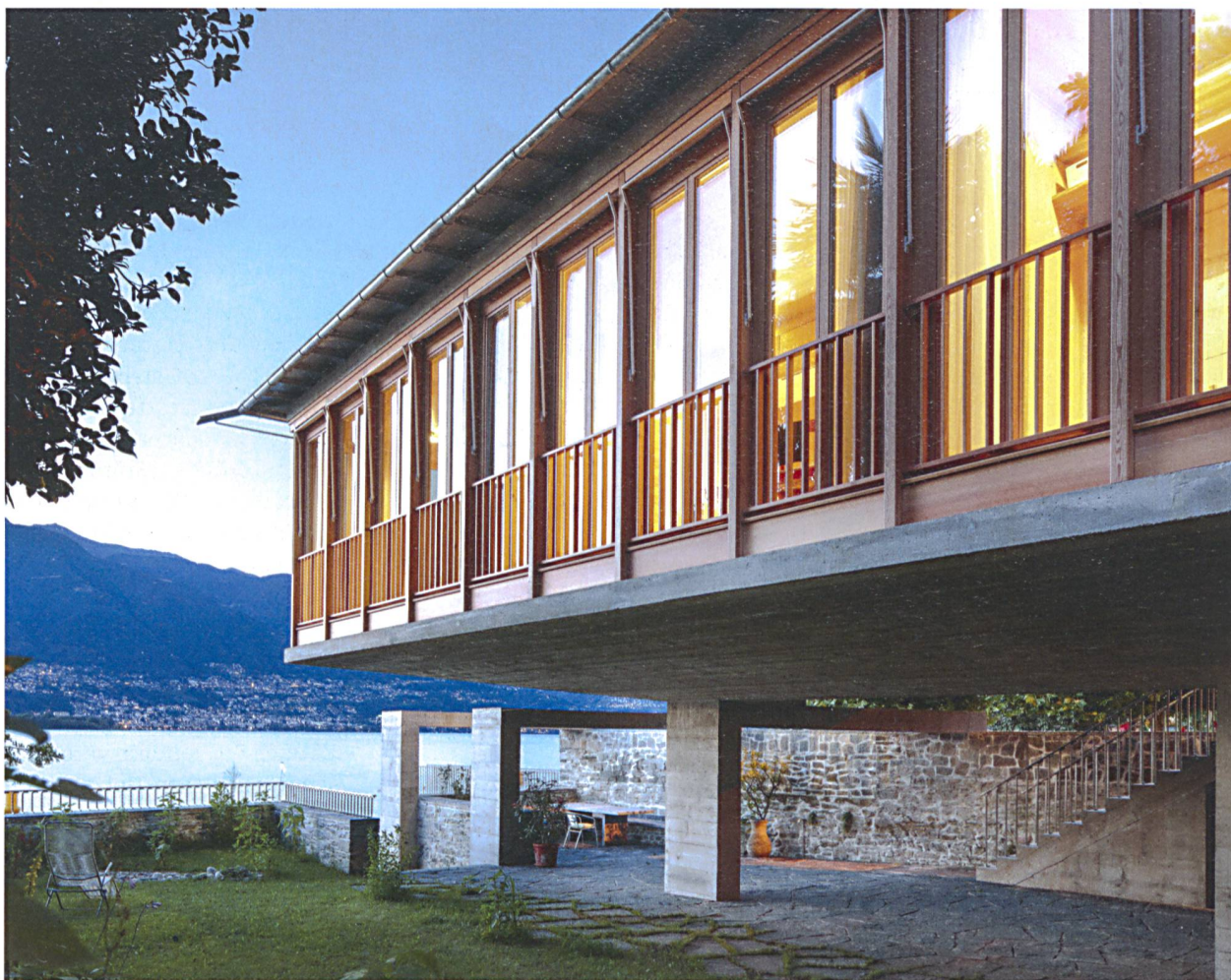
Wie ein aufgedocktes Schiff liegt das Bootshaus am Lago Maggiore. Die zwei Bügel im vorderen Bereich haben keine statische Funktion und bilden lediglich eine Pergola über der Terrasse am See.
