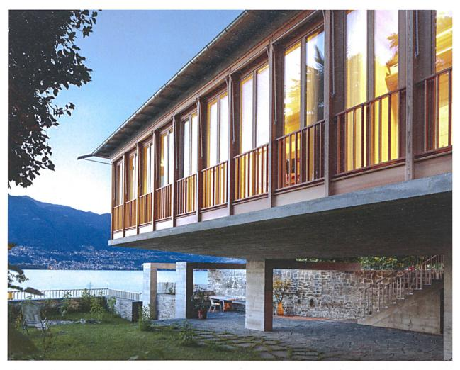
Wie ein aufgedocktes Schiff liegt das Bootshaus am Lago Maggiore. **Die zwei Bügel im vorderen Bereich** haben keine statische Funktion und **bilden lediglich eine Pergola** über der Terrasse am See.
