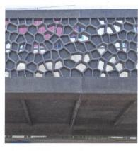
Links: Die Negativform des «organischen» Musters wurde mit einer PVC-Matrix realisiert. Rechts: «organischer» Steg und Fuge zwischen zwei Fertigteilen.
