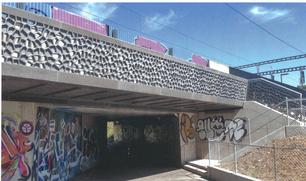
Der «organische» Steg wurde in Zusammenarbeit zwischen Bauingenieuren und Stadtarchitekten entwickelt. Er weist ein möglichst offenes Lochmuster auf und bleibt zugleich statisch effizient.
