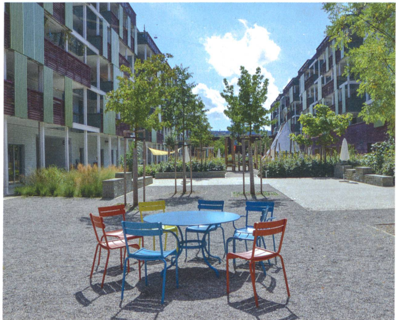
Der Hof zwischen den beiden Gebäudeflügeln des Mehrgenerationenhauses Giesserei in Winterthur wirkt wie ein urbaner Platz und wird auch so genutzt.
