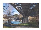
Der historischen Hinterrheinbrücke im bündnerischen Reichenau soll eine zweite Eisenbahnbrücke zur Seite gestellt werden, um die instandsetzungsbedürftige Konstruktion zu entlasten.
