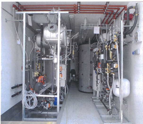
Systemaufbau: Auf dem CAD-Bild (ganz oben) und im realisierten Prototyp (oben) sind auf der linken Seite der Sorptionspeicher und auf der rechten Seite der sensible Speicher aufgebaut.
