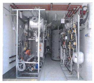
Systemaufbau: Auf dem CAD-Bild (ganz oben) und im realisierten Prototyp (oben) sind auf der linken Seite der Sorptionsspeicher und auf der rechten Seite der sensible Speicher aufgebaut.
