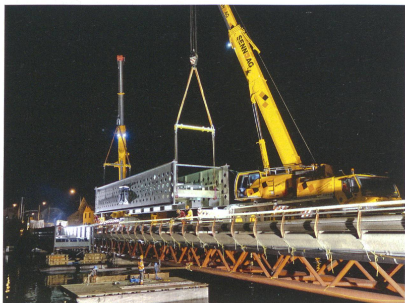
Montage des Brückenüberbaus von der benachbarten Strassenbrücke aus.
