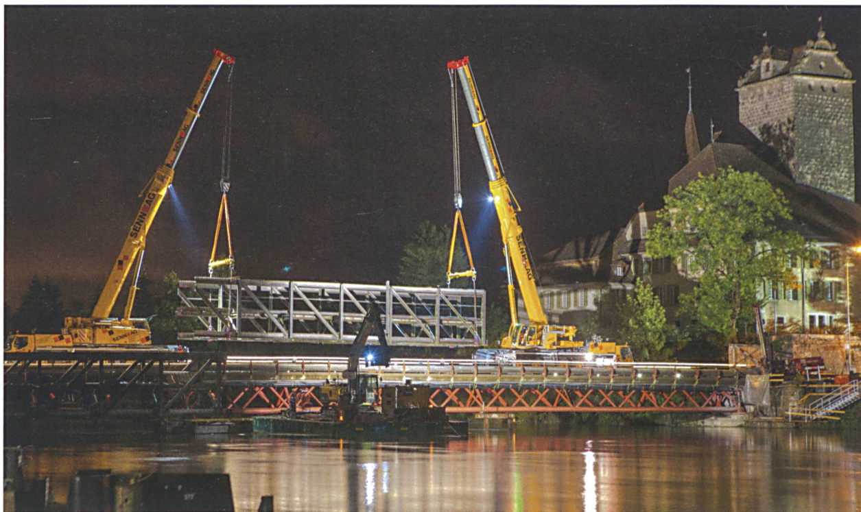
Die bestehende Bahnbrücke wird in vier Segmenten und vier Nachtschichten von der benachbarten Strassenbrücke aus rückgebaut, quasi ohne Hilfsgerüste. Die Montage der neuen Bahnbrücke erfolgt in der genau umgekehrten Reihenfolge.
