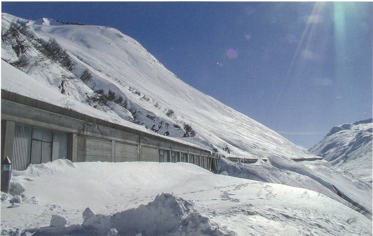
Lawinengalerie Scopi im Winter. Die Lukmanierstrasse wird nördlich der Passhöhe durch viele Lawinenzüge gefährdet. Zum Schutz des Verkehrs wurde in den 1960er-Jahren die etwa 2 km lange Lawinengalerie Scopi gebaut. Im Winter ist die Galerie zum Teil beinahe vollständig mit Schnee von Lawinniedergängen eingedeckt.
