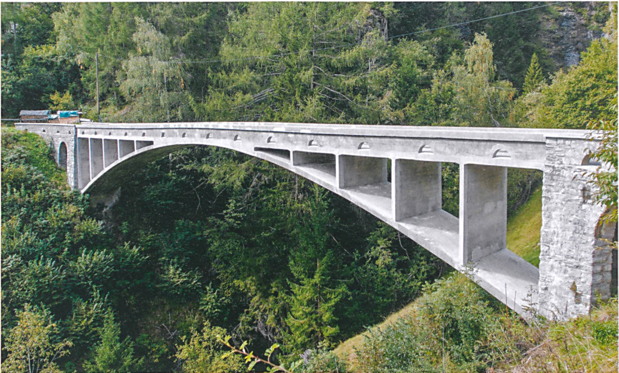
Eine der frühen versteiften Stabbogenbrücken: die Valtischelbrücke in Donat. Ingenieur: Robert Maillart; Bauherr: Gemeinde Donat; Instandsetzung: Conzett Bronzini Partner, Chur.
