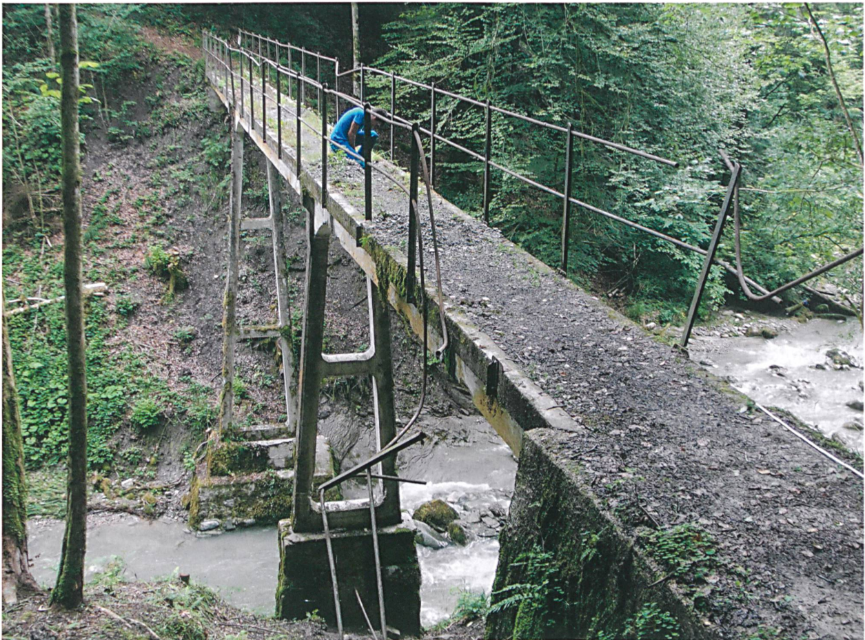
Möglicherweise die erste Brücke mit leiterförmigen Stützen aus Eisenbeton: die Hebeltobelbrücke Uznach vor der Instandsetzung. Ingenieur: Locher&Cie, Zürich; Bauherr: Gemeinden St. Gallenkappel und Uznach; Instandsetzung: Conzett Bronzini Partner, Chur.
