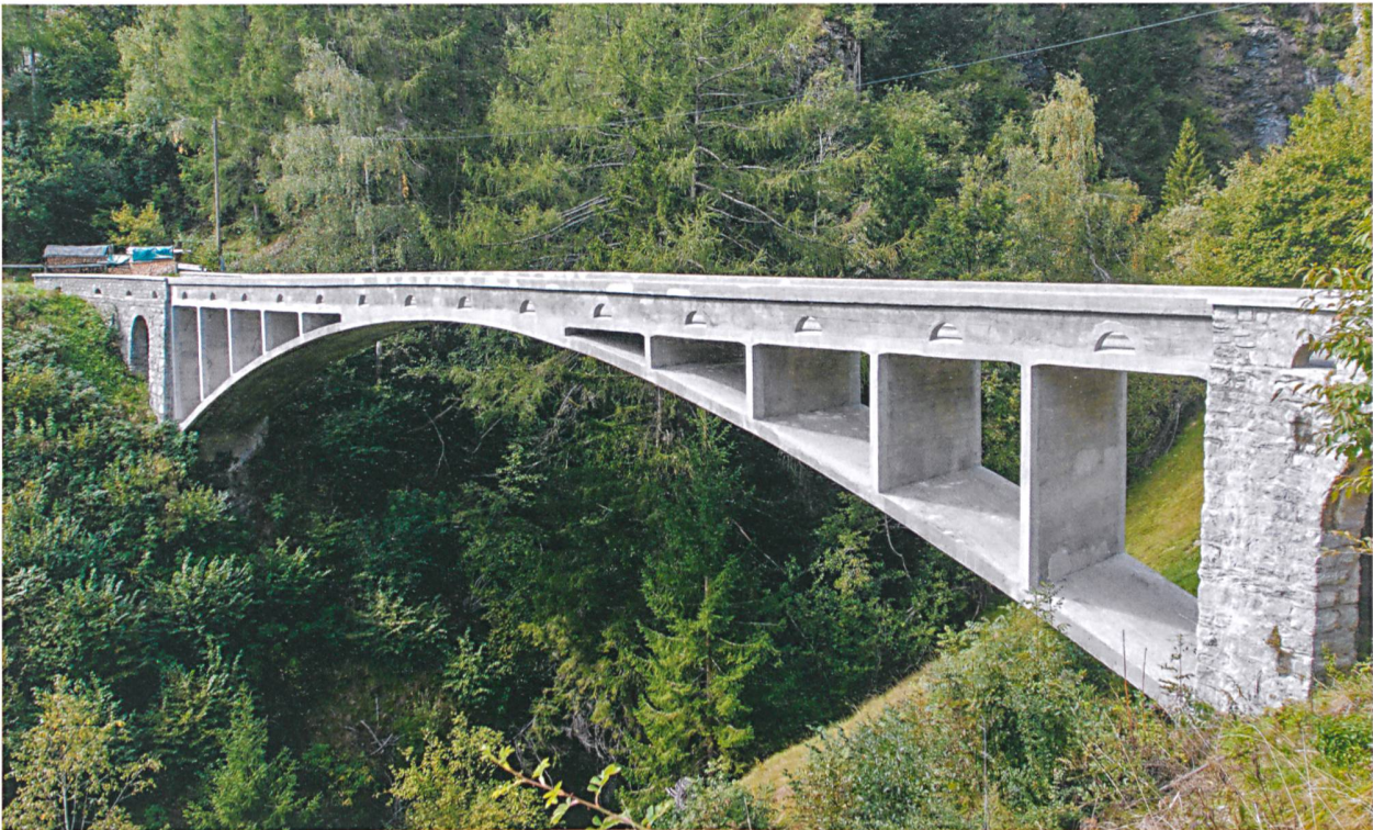
Eine der frühen versteiften Stabbogenbrücken: die Valtshielbrücke in Donat. Ingenieur: Robert Maillart; Bauherr: Gemeinde Donat; Instandsetzung: Conzett Bronzini Partner, Chur.
