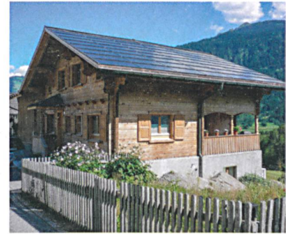
Norman Foster Solar Diplom für ein Wohnhaus in Schluein GR: Der Strickbau aus den 1950er-Jahren wurde saniert und erneuert. Die Solaranlage auf dem Dach ist sorgfältig ausgeführt, verändert aber dennoch den Charakter des Hauses grundlegend.
