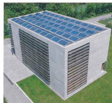
«Norman Foster Solar Award»-Preisträger 2015 ist der Firmensitz der Cavigelli Ingenieure in Ilanz GR. Die Solaranlage auf dem Dach (Abb. unten) ist nur von oben zu sehen. Lamellen verschatten die Fenster und tragen zur guten Energiebilanz bei.
