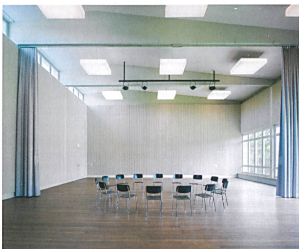
Von Turnhalle zu Aula: Holzlamellen an den Wänden verbessern die Akustik, raumhohe Vorhänge in der Mitte erlauben eine Zonierung. Die Dachträger sind von der Aussenfassade zum Foyer trapezförmig von 0.45 x 1.35 m in der Höhe zunehmend.
