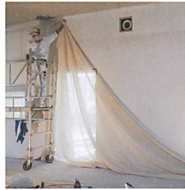
Montage des Stramins in den Fluren.
