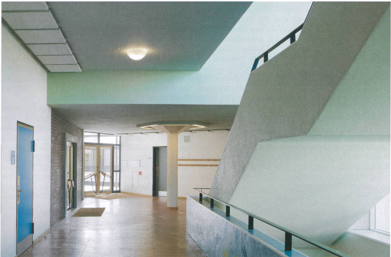
Seiteneingang der Schule (Trakt B) mit charakteristischer Pilzstütze und dem Treppenaufgang zum OG. Die Mosaiken von Charles Hindelang wurden aufgefrischt, ebenso die Böden aus gelbem und rotem Klinker. Neu erhöhen Brandschutzmassnahmen und eine Evakuationsanlage die Sicherheit. Die notwendige Unterteilung der Korridore wurde in der Haupteerschliessungsachse mittels magnetauslösender Drehflügeltüren realisiert, die diskret in Wandnischen versteckt sind.
