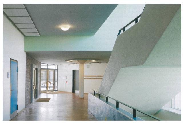
Seiteneingang der Schule (Trakt B) mit charakteristischer Pilzstütze und dem Treppenaufgang zum OG. Die Mosaiken von Charles Hindelang wurden aufgefrischt, ebenso die Böden aus gelbem und rotem Klinker. Neu erhöhen Brandschutzmassnahmen und eine Evakuationsanlage die Sicherheit. Die notwendige Unterteilung der Korridore wurde in der Haupterschliessungsachse mittels magnetauslösender Drehflügeltüren realisiert, die diskret in Wandnischen versteckt sind.
