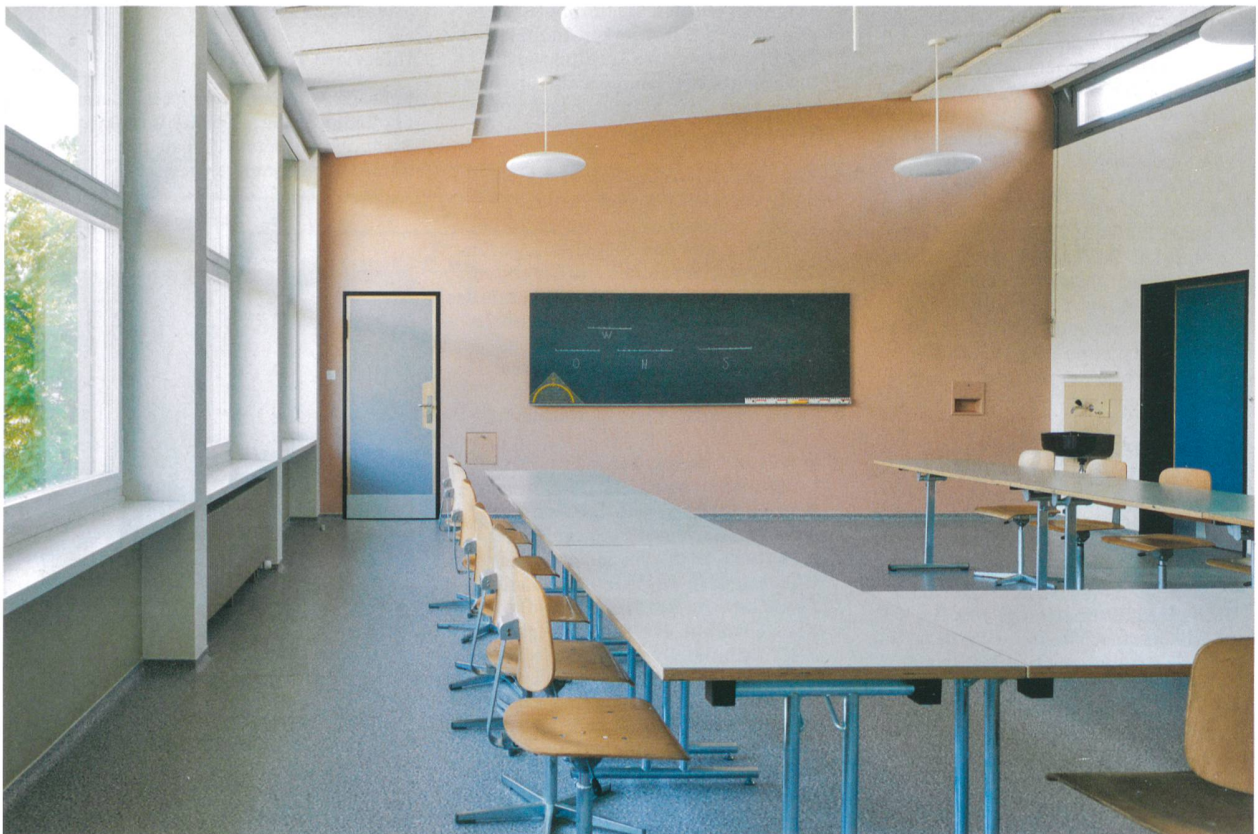
Klassenzimmer nach der Sanierung. Die bestehenden Akustikplatten wurden an der Fassadenseite um eine zusätzliche Reihe ergänzt, die Platten sind ein Nachbau im gleichen Stil. Bei den Beleuchtungskörpern setzten die Architekten auf eine Hybridlösung: Der Unterbau ist eine industriell gefertigte Pendelleuchte, die Befestigungsstäbe sind individuell beschichtet.
