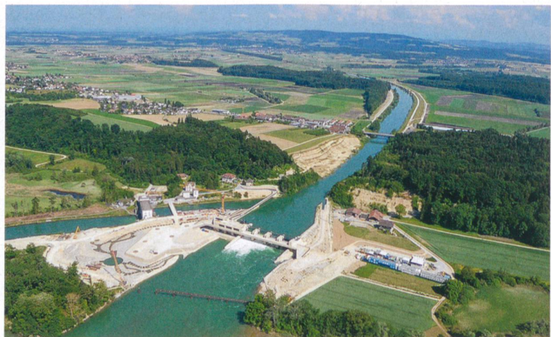
Mündung der Aare in den Bielersee, im Vordergrund das neue Kraftwerk, dahinter der Hagneckeinschnitt mit dem abgetragenen Fels (links oben).
