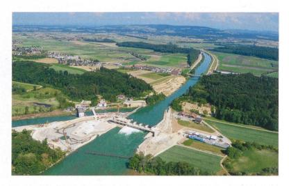
Mündung der Aare in den Bielersee, im Vordergrund das neue Kraftwerk, dahinter der Hagneckeinschnitt mit dem abgetragenen Fels (links oben).
