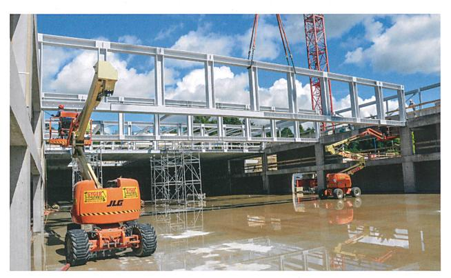
Montage der 30 t schweren Vierendeelträger. In der Trägerhöhe über der Schiesshalle werden diverse Nutzungen in einem 10.80×3.06 m Raster, ohne tragende Wände oder Fachwerkdiagonalen, untergebracht.
