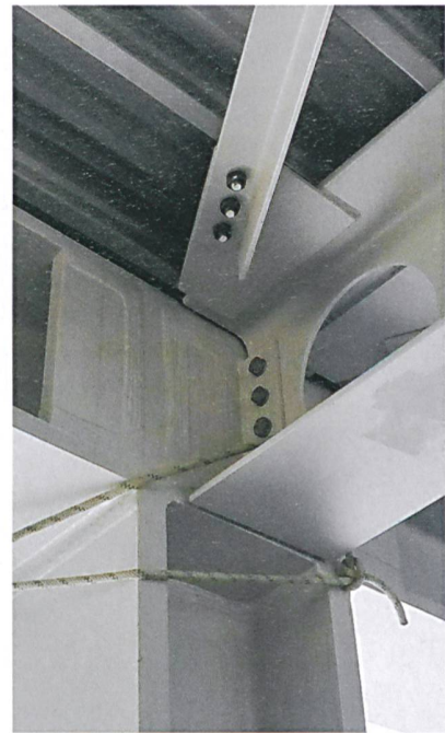
Links: Erdgeschossaufbau. Rechts: biegesteife Ausbildung der Knoten des Vierendeelträgers. Die umfangreichen Schweissarbeiten im Werk betrugen etwa 750 Stunden pro Träger.
