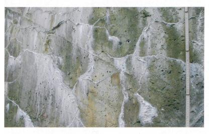
**Typisches Rissbild einer AAR.** Erst durch eine stichprobenartige mikroskopische Gefügeanalyse wird sie aber zuverlässig nachgewiesen.
