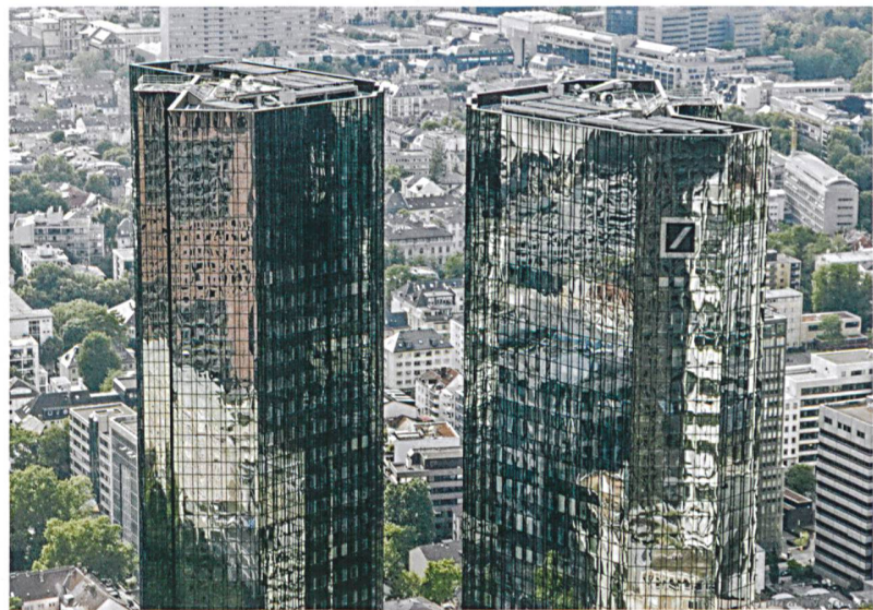
Die Biegespannung und Auswölbung infolge des «Isolierglas-Effekts» ist bei 3-fach-ISO stärker als bisher angenommen.
