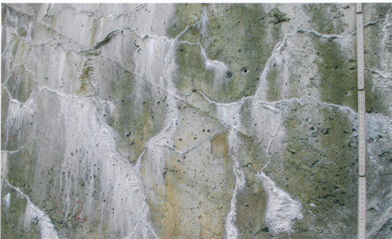
Typisches Rissbild einer AAR. Erst durch eine stichprobenartige mikroskopische Gefügeanalyse wird sie aber zuverlässig nachgewiesen.
